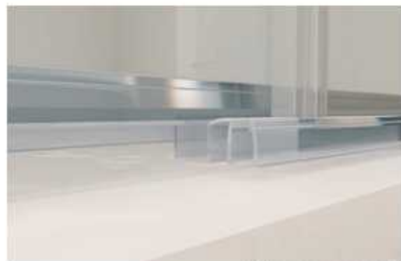
Detalle verteaguas exterior
